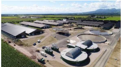
バイオガスプラント
